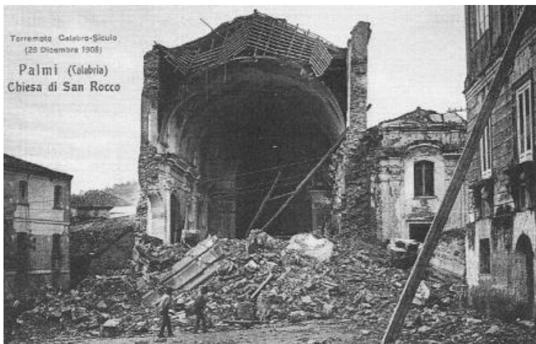
Рис.1. Разрушение церкви Сан-Рокко
