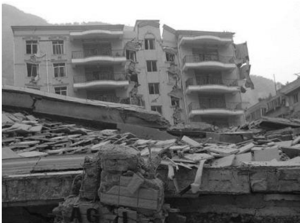
Рис. 11. Последствия Сычуаньского землетрясения
