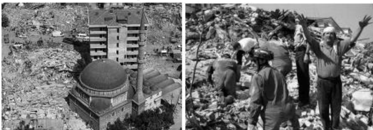
Рис. 10. Последствия Измитского землетрясения
