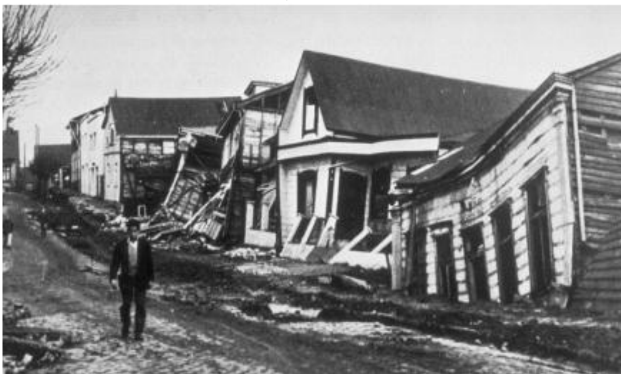
Рис. 3. Последствия Чилийского землетрясения
