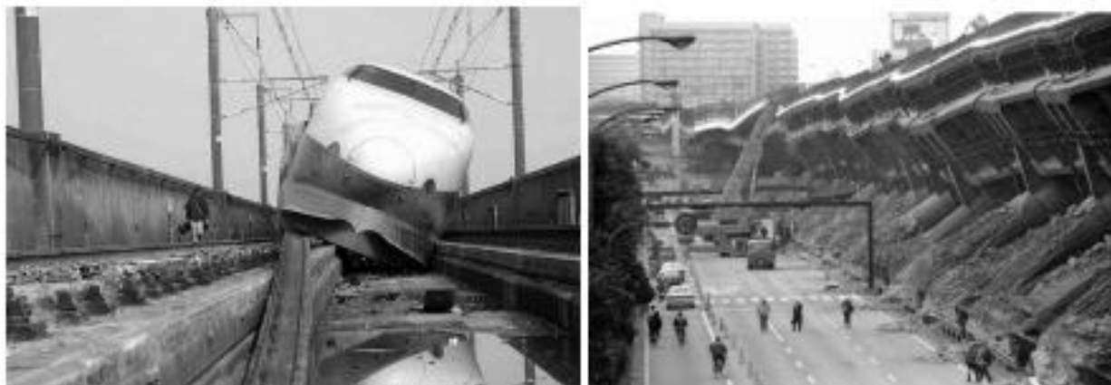
Рис.9. Последствия землетрясения в Кобе
