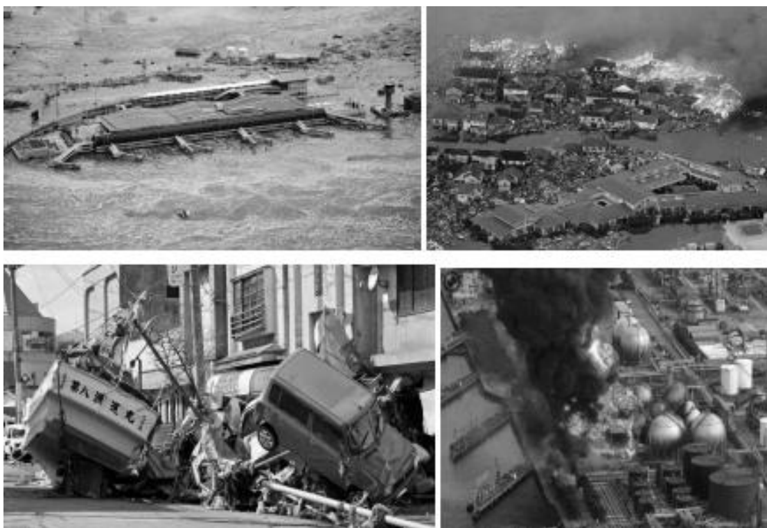
Рис.12. Последствия землетрясения в Японии 11.03.2011 г.
